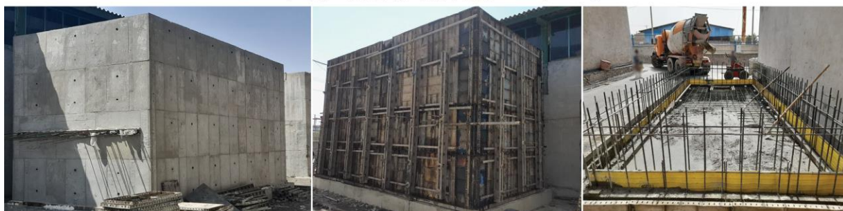
ساخت مخازن ذخیره لجن، سیستم بی‌هوازی UABR و...
