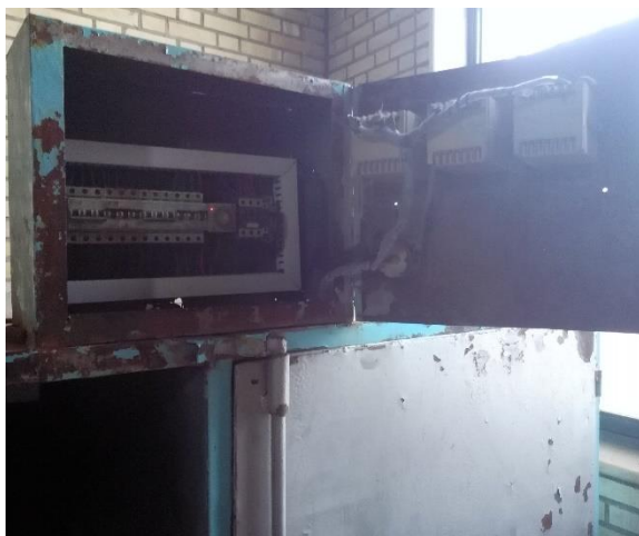
تصویر ۳- تابلو اصلاح شده
