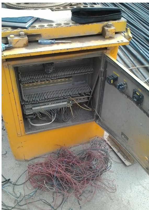
تصویر ۲- تابلو در حال اصلاح
